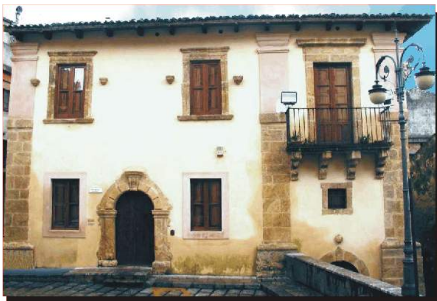
La Biblioteca Comunale. Palazzo Mastroieni-Longo , fu costruito tra la fine del '500 ed i primi del '600 per la nobile famiglia Mastroieni di cui, ancora oggi, si può ammirare lo stemma sullo spigolo sinistro della facciata prospiciente alla Piazza Duomo. Oggi proprietà del Comune di Mandanici è sede di una attrezzata biblioteca con antichi volumi di Miceli, abate, studioso del luogo e poi vescovo di Lipari.
